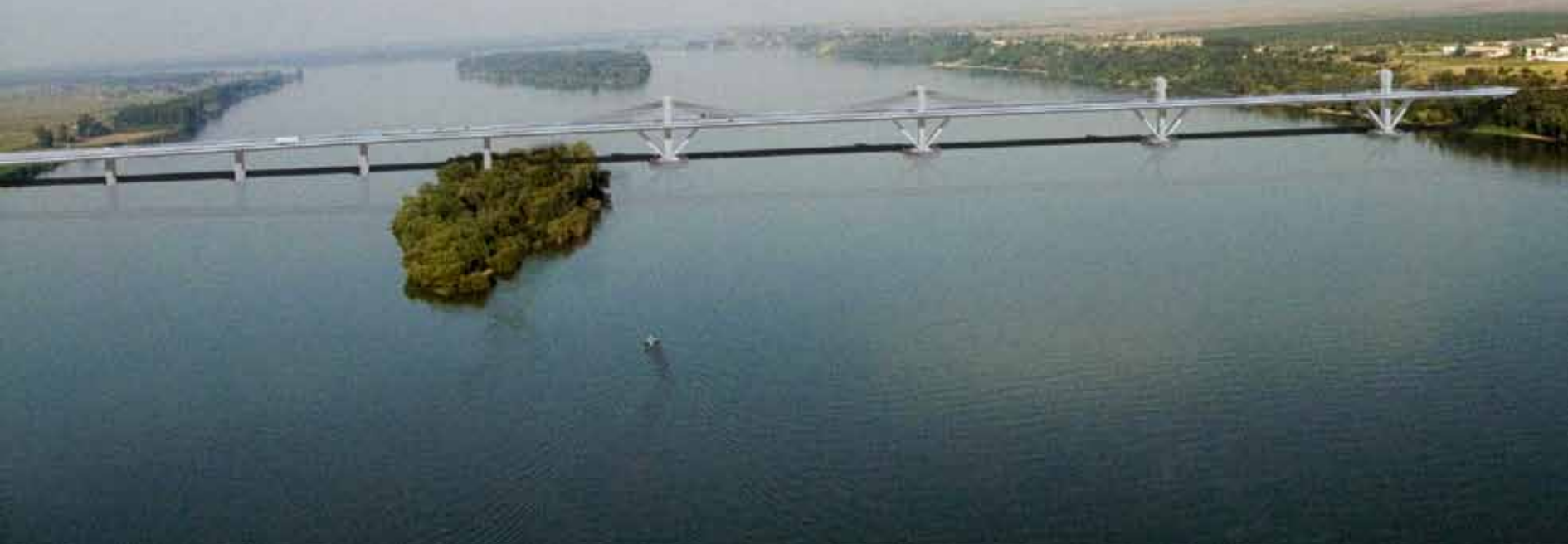
Vue panoramique du nouveau pont enjambant le Danube
