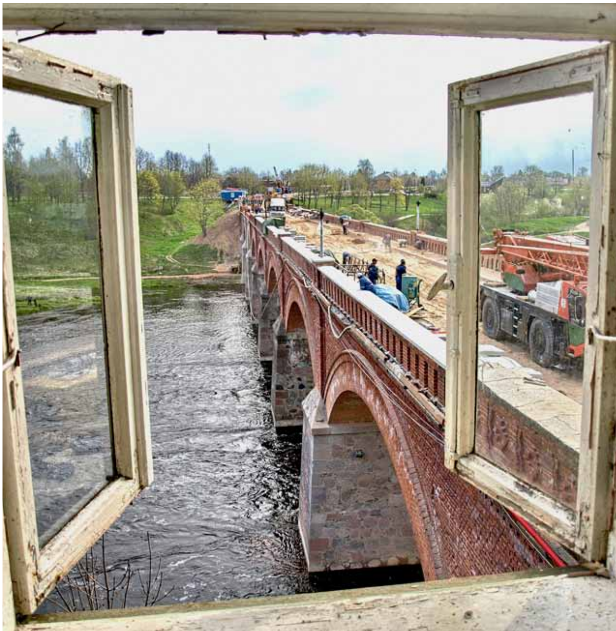
Travaux de restauration en cours sur le vieux pont de la rivière Venta
