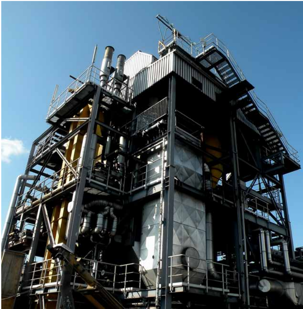
Une usine gazéifie du bois pour produire de la chaleur, de l'électricité et du diesel synthétique
