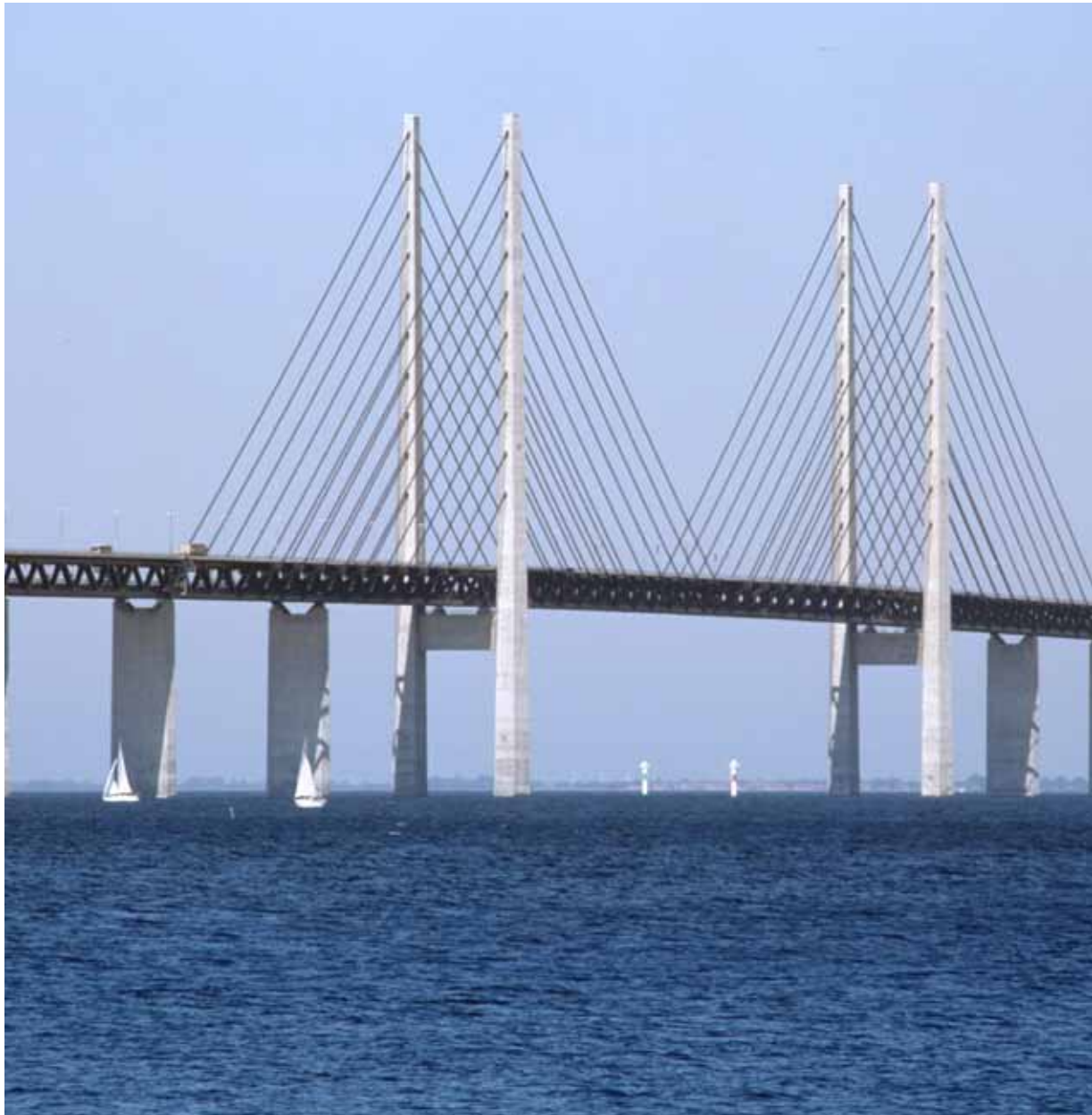
Construction du pont d'Øresund
